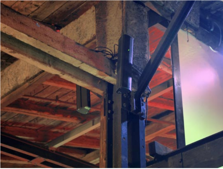
Pan Beam Linienstrahler vom Typ PB 04 und PB 08 werden auf der Galerie als Stütz- bzw. Delaysysteme eingesetzt.
